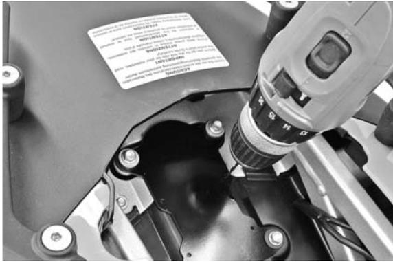
Durch die vier Löcher des Montageblechs mit einem 2,5 mm Bohrer vorsichtig durch das Staufach bohren. Nicht zu tief bohren, um den darunterliegenden Kotflügel nicht zu beschädigen.
